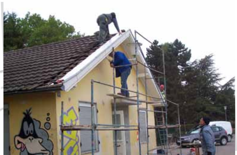
Les travaux en cours
